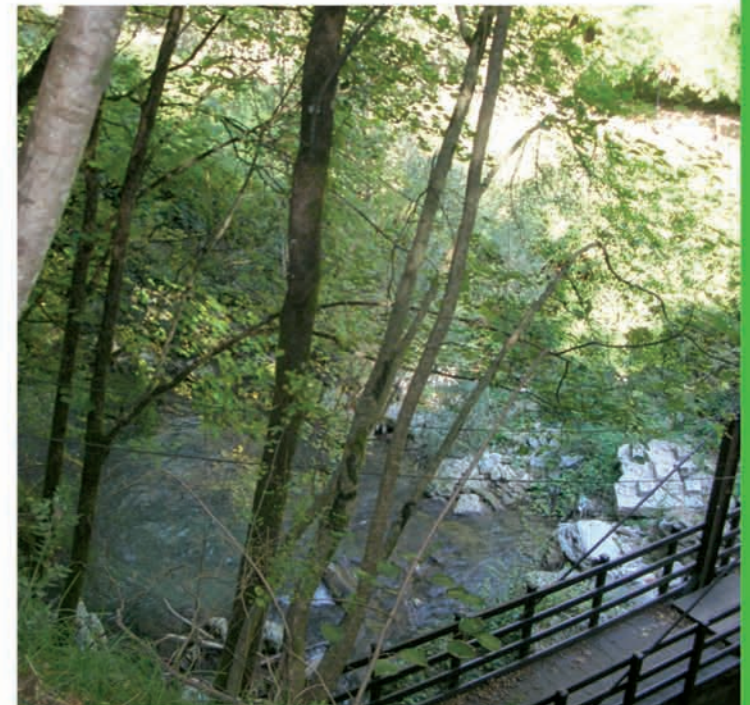
Ponticello in legno per attraversamento del fiume
